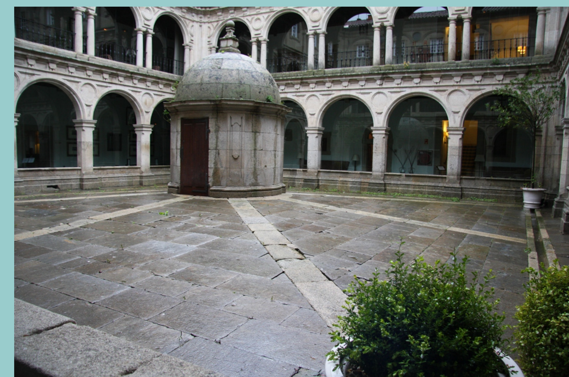
Patio da alxibe do mosteiro de San Vicente do Pino en Monforte. No centro o acceso ao interior do depósito no que se almacena a auga que se recolle da chuva por medio dun sistema de rampas e canles.
